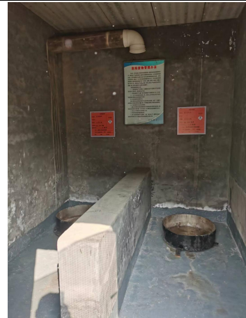
危废间废气收集
